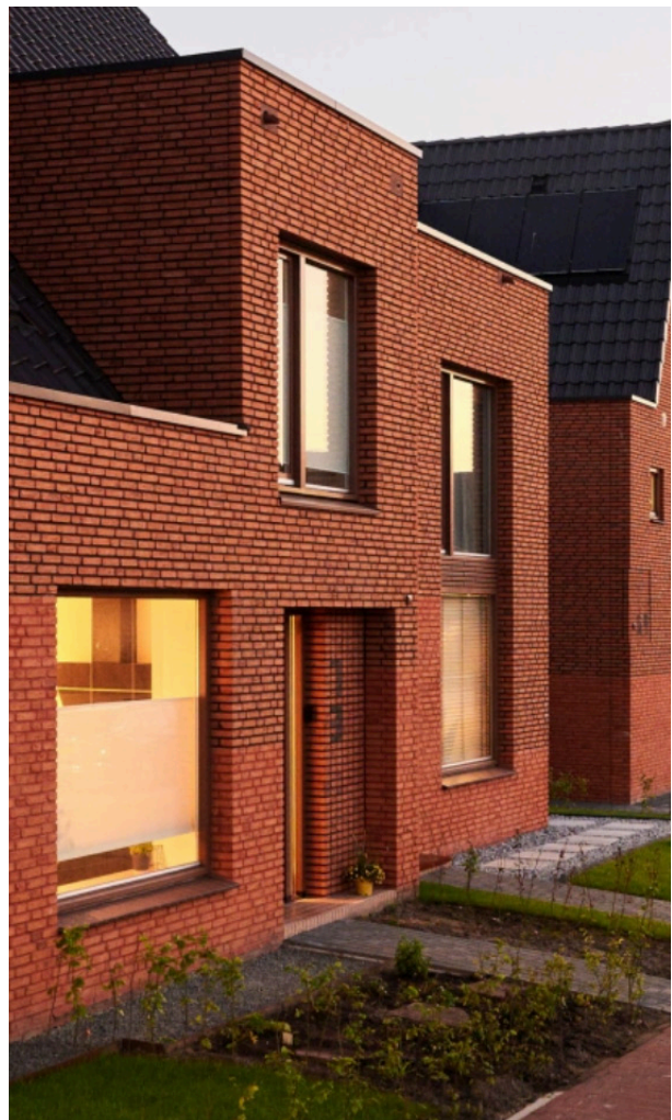
Entrees krijgen een uitnodigend karakter, bijvoorbeeld doordat deze zijn teruggelegen in de gevel waardoor een voorportaal ontstaat (bron: vector-i.nl/).
