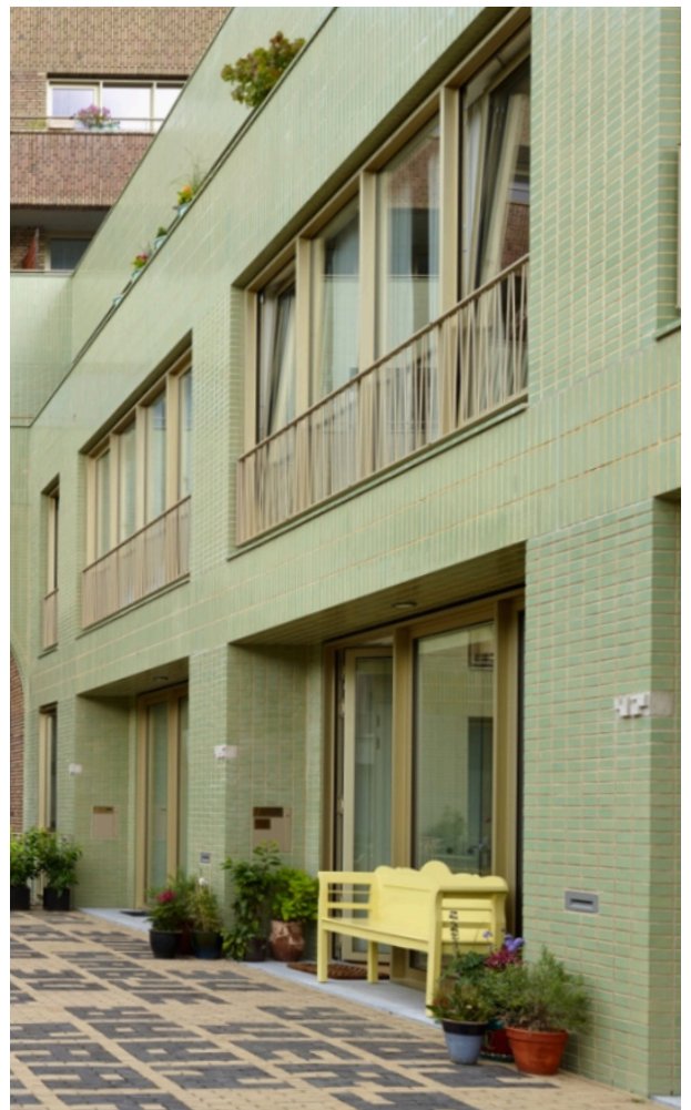
Buitenruimtes zoals balkons, dakterrassen en zitgelegenheden in de gevel zorgen voor een levendige relatie tussen bebouwing en het Stadspark (bron: marcellok.nl/)
