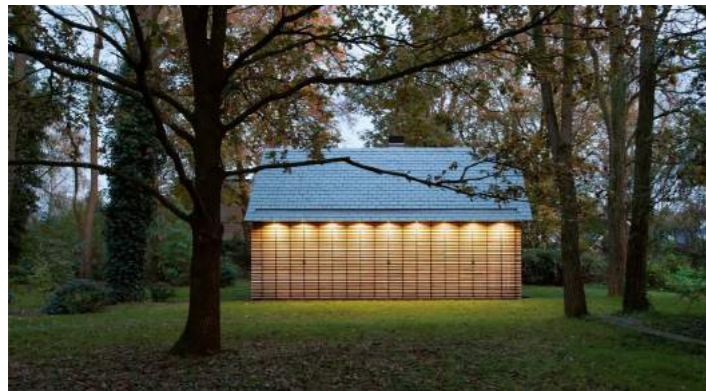
Referentie: verlichting gebouw in overstek
