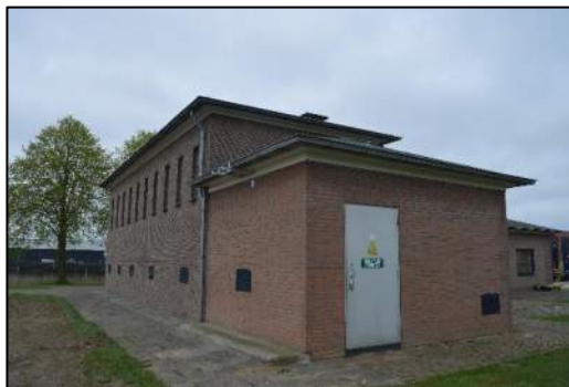
Figuur 4.4. Hoogspanningsstation Goor op station Brownfield.
