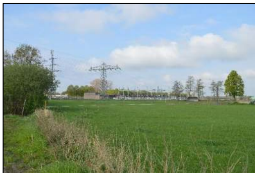
Figuur 4.12. Station Brownfield, gezien vanaf station Greenfield.
