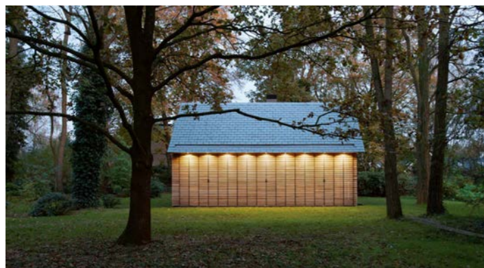
Referentie: verlichting gebouw in overstek
