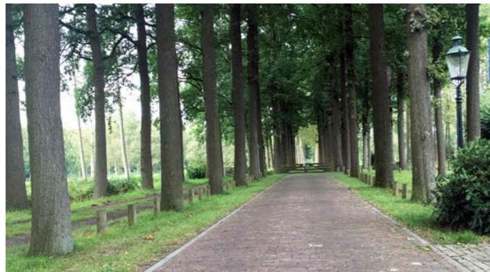
Referentie toegangsweg: gebakken klinker met opsluitband.
