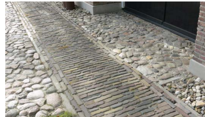
Referentie erven: gebakken materiaal en boerenkasseien in cement
