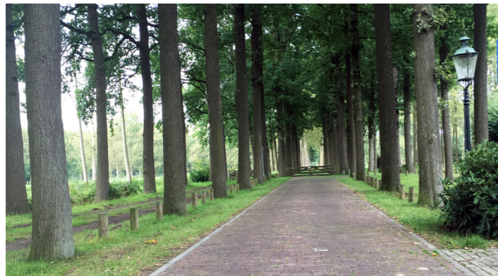
Referentie toegangsweg: gebakken klinker met opsluitband.
