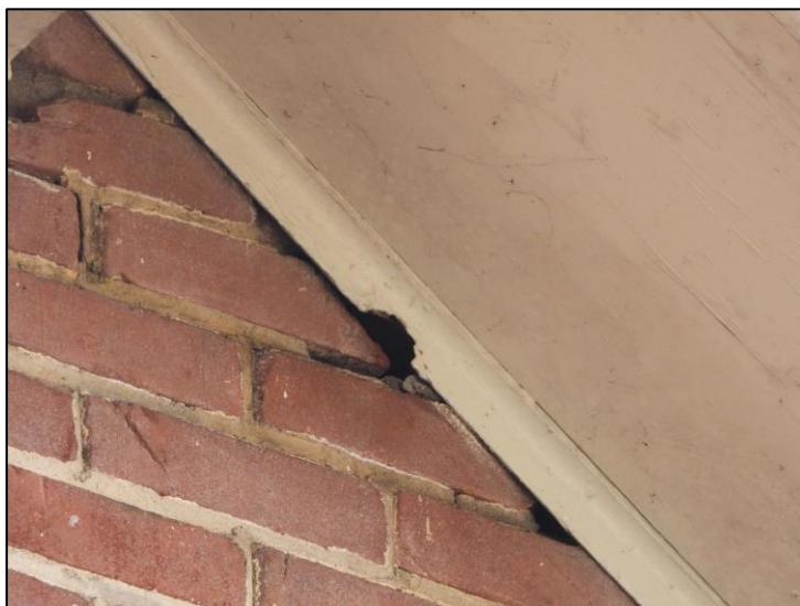
Kieren tussen de buitengevel en de dak overstek kunnen als invlieg opening gebruikt worden door gierzwaluwen. Gierzwaluwen kunnen hier een nestplaats hebben.
