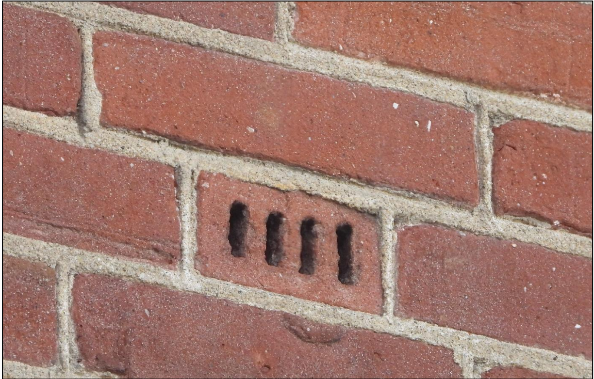
Ventilatieopeningen in de buitengevel van de woning zijn toegankelijk voor vleermuizen waardoor ze een rust- of voortplantingsplaats kunnen bezetten in de spouw.
