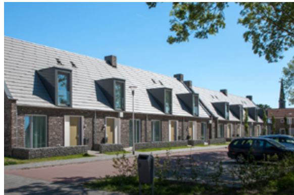
Afbeelding 8: Rijwoningen met dakkapel aan de voorzijde
