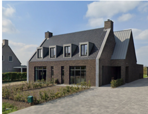
Afbeelding 6: Twee-onder-een-kapwoning met open voorgevel
