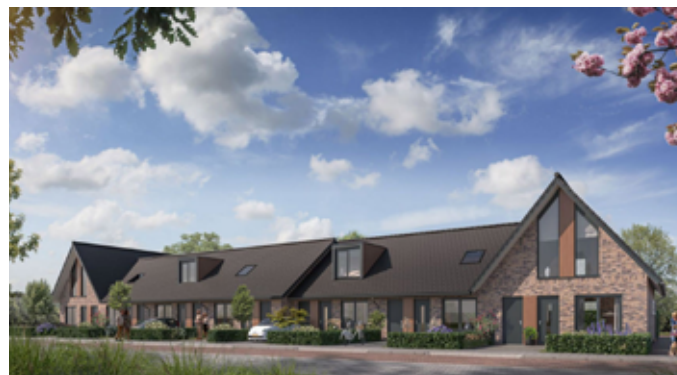
Afbeelding 11: Rijwoningen met compacte hoofdvorm en kapverdraaiing
