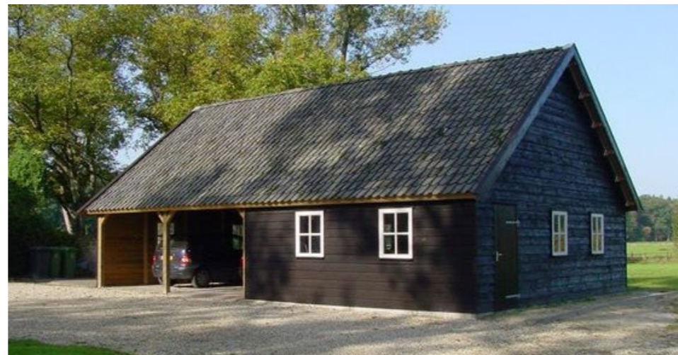
Schuren, ondergeschikt aan woonhuis, halfopen met zichtbare balken. betimmerd met zwart geteerde planken.
