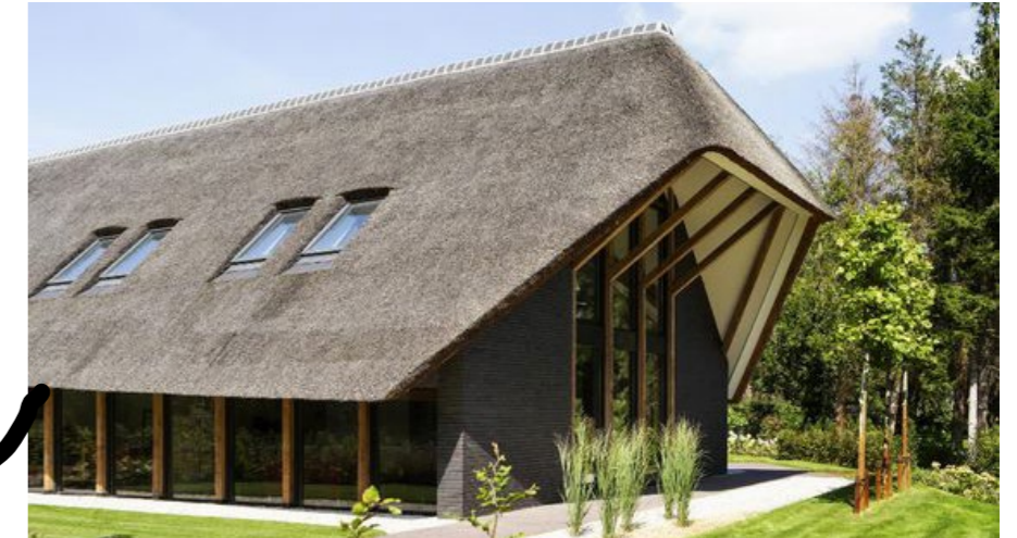
De hoogte van de rechtgaande muur van de begane grond ten opzichte van het schuinopgaande dak is het liefst zo klein mogelijk.
