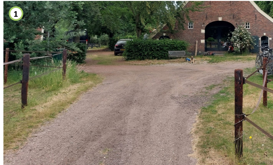
Aansluiten bij de bestaande halfverharding 'Mijnsteen'
