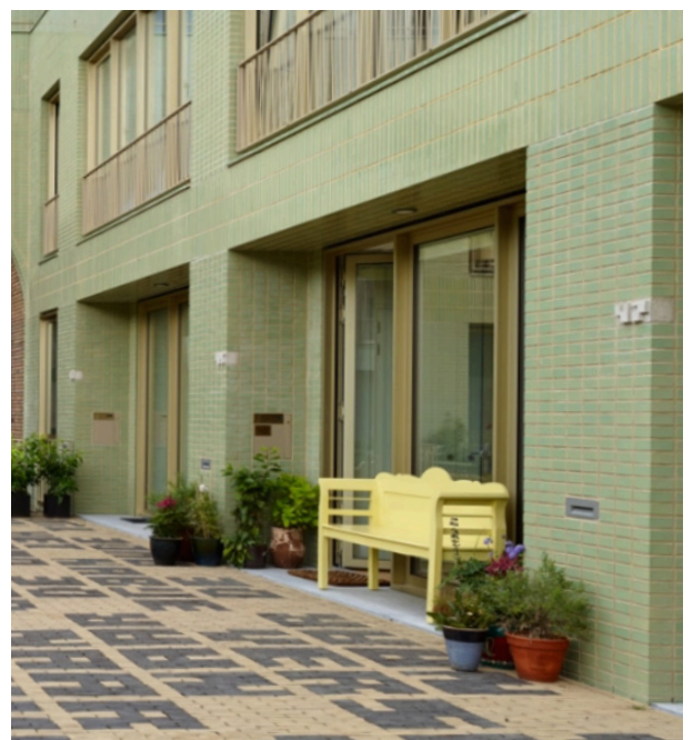
Buitenruimtes zoals balkons, dakterrassen en zitgelegenheden in de gevel zorgen voor een levendige relatie tussen bebouwing en het Stadspark (bron: marcello.nl/)
