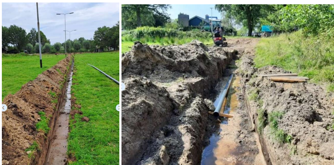
Afbeelding 2.3: Grondroerende werkzaamheden i.v.m. vervanging pomp en leidingwerk (bron Facebook)
