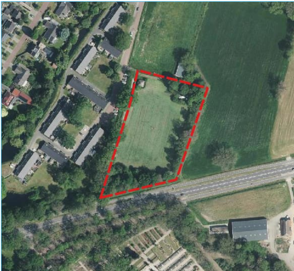
Figuur 1.1: Locatie brandweerkazerne (bron luchtfoto: pdok)
