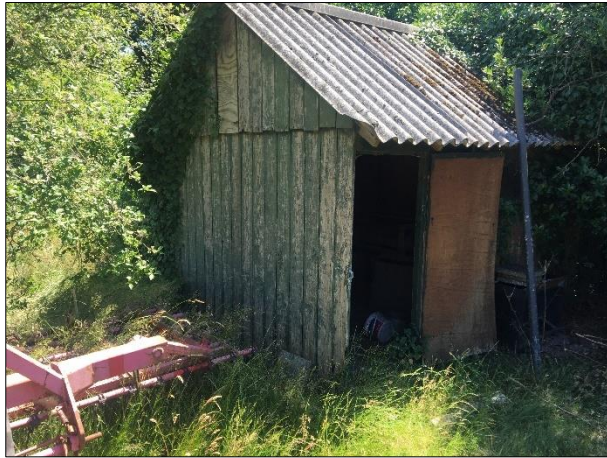
Potentiële locatie voor een rust- of voortplantingsplaats van grondgebonden zoogdieren in het te slopen schuurtje.
