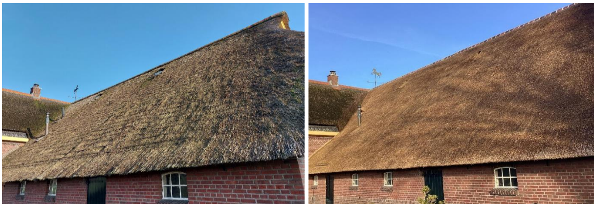
Afbeelding van de situatie voor en na het vervangen van het rieten dak waarvoor subsidie is verleend.
