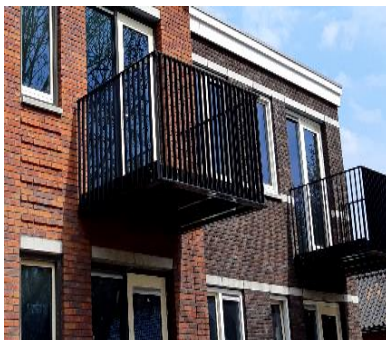
Voorbeeld van balkon met zwarte verticale balustrade
